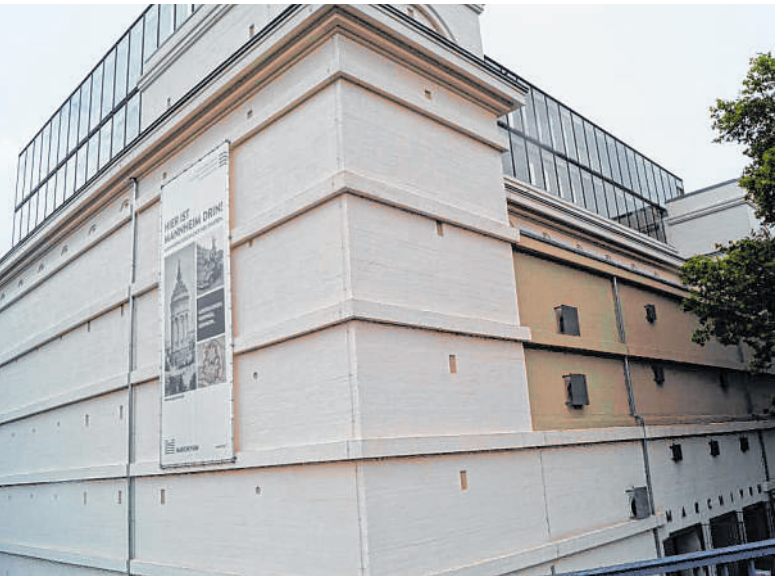
Ausgezeichnet wird der Marchivum-Umbau mit Aufstockung eines Hochbunkers.
