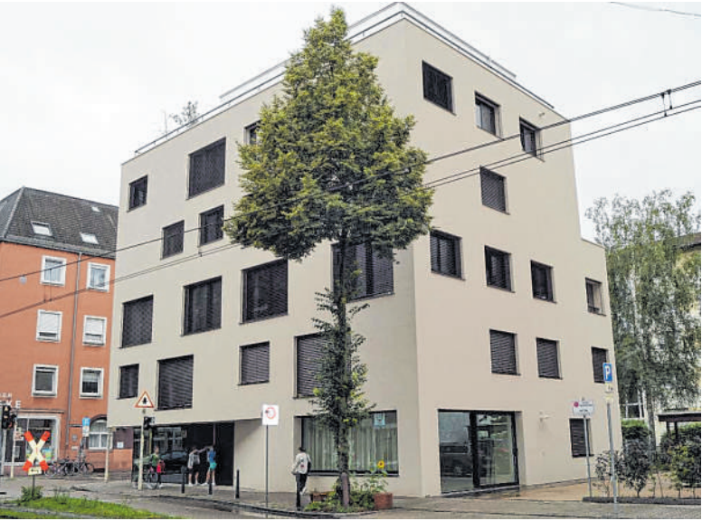
Das Gebäude der Baugesellschaft meerGlück in der Meerfeldstraße fördert Kooperation und Integration.
